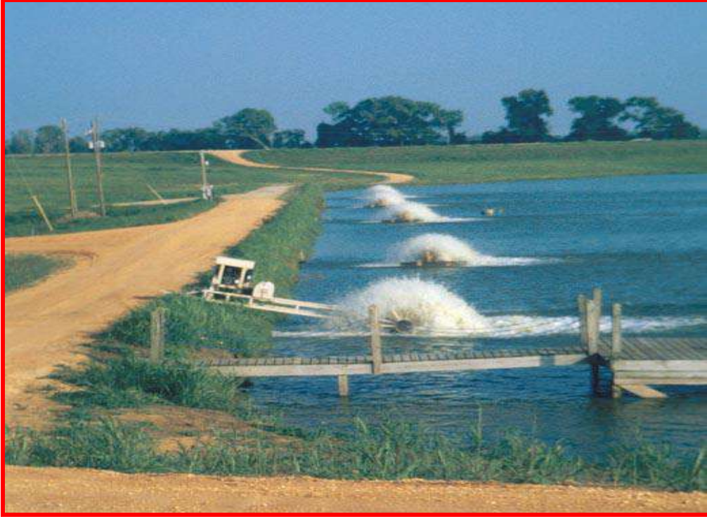
الشكل ١١ - ٣ طريقة العجلات الدوارة لتهوية احواض التربية
